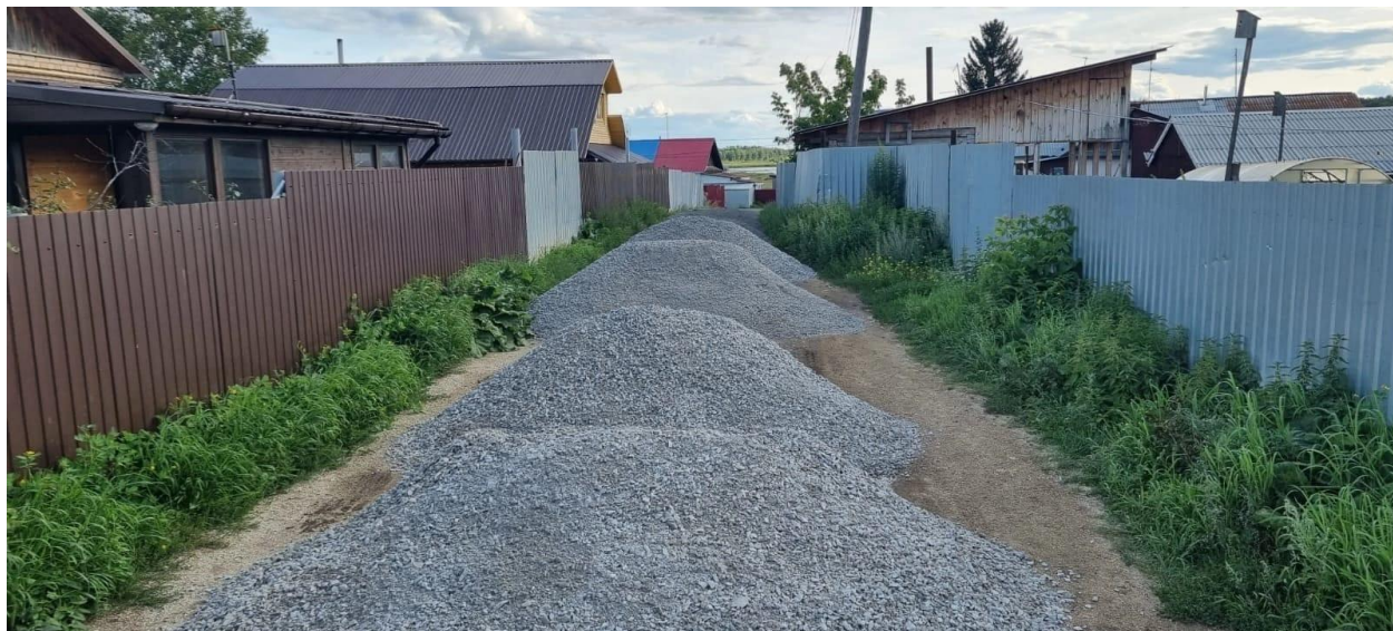
Отсыпка дорог местного значения
