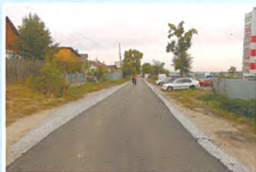
заасфальтирован дорожный проезд к школе №22
